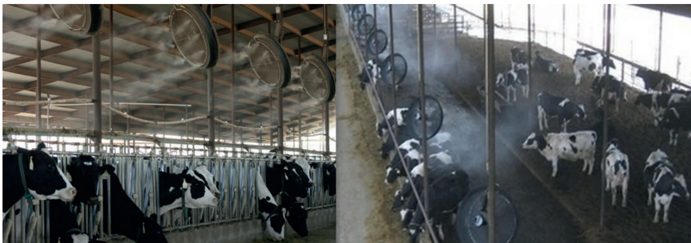
► Увлажнение воздуха распылением воды
